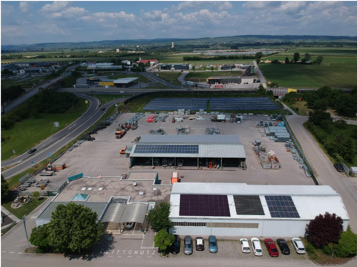
Abbildung 2: Betriebsgelände mit Photovoltaikanlagen
