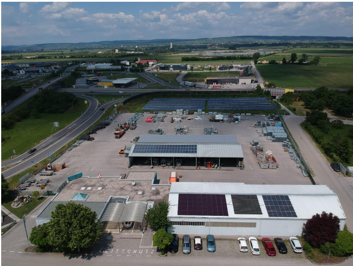
Abbildung 2: Betriebsgelände mit Photovoltaikanlagen
